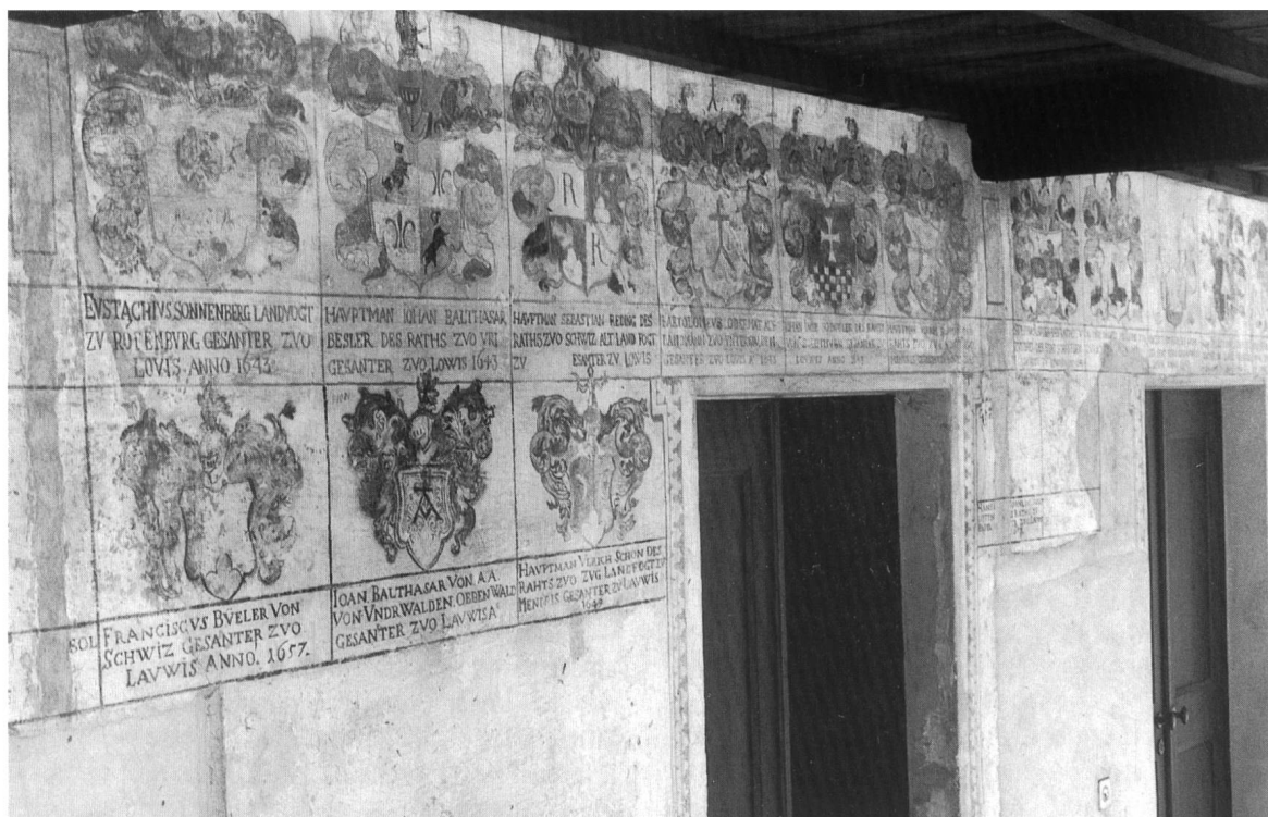
Scorcio del loggiato al primo piano della locanda dei sindacatori svizzeri alla Bricola. Sulla parete interna appaiono ancora oggi parecchi stemmi e motti, ma non più totalmente leggibili, di sindacatori dei dodici cantoni che, tra il 1655 e il 1730 circa, si incontravano a Rivera, nell'agosto di ogni anno, prima di partire insieme, a cavallo, per Lugano.
