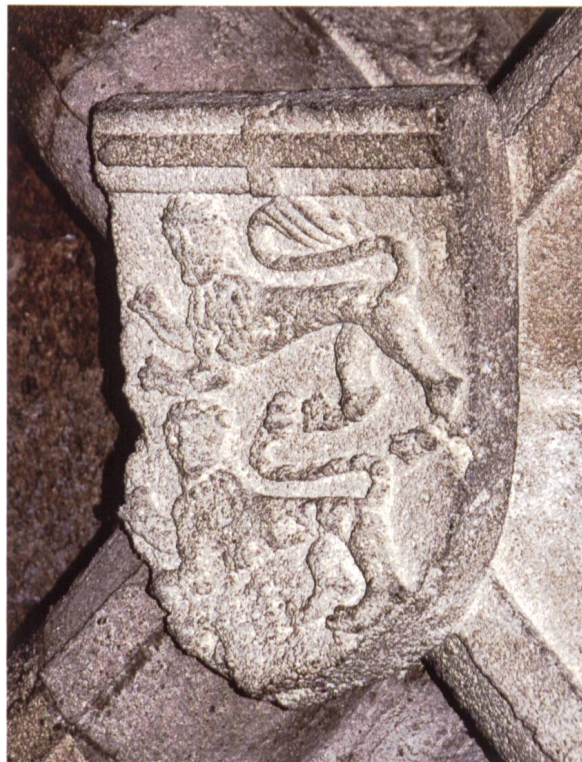
Fig. 58 Ecu aux armes du commandeur Guy de Blanchefort à la clef de voûte de la maison du prieur d'Auvergne (cl.JBV).
