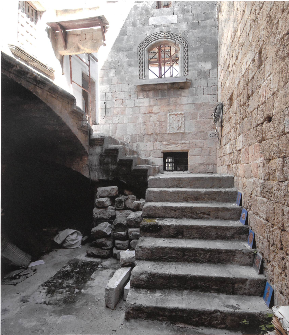
Fig. 30 L'entrée, vue intérieure (cl.JBV) PAS7506
