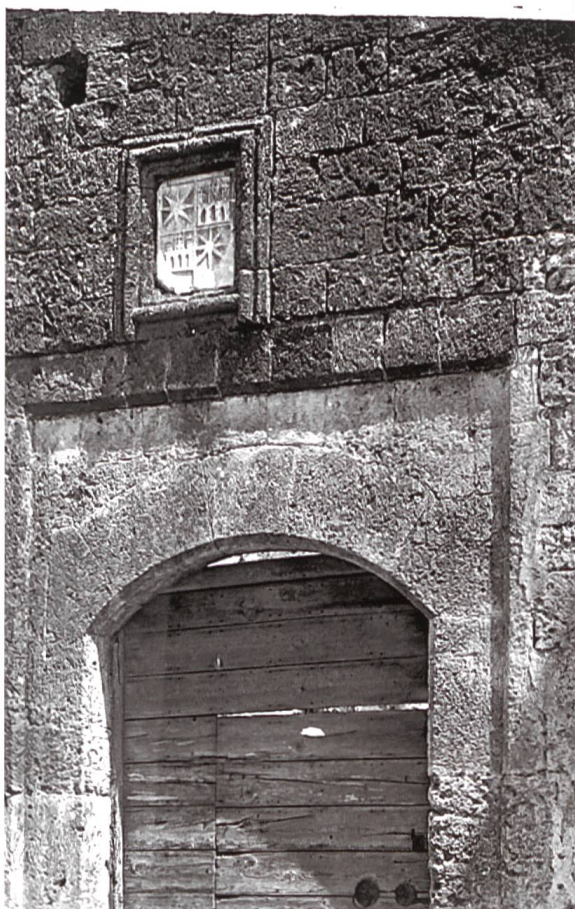
Fig. 8 Ancien portail dans une feuillure, surmonté d'un caisson. État en 1920
