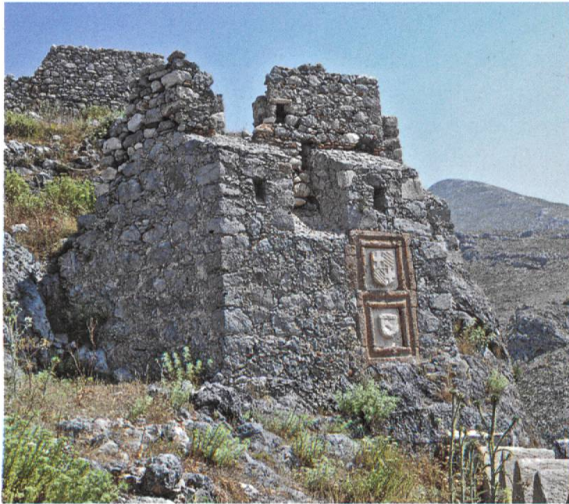
Fig. 10 Chorio. Bastion oriental (cl. JBV)
