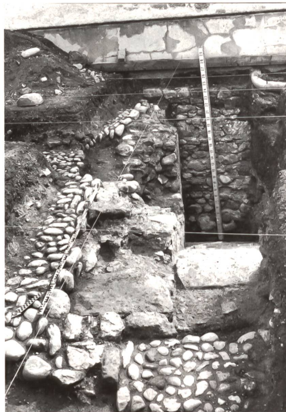
Abb. 11: Embrach Treppe zum Stock, nördl. der Kirche 7736-9, Grabungskampagne 1977, Reformierte Kirche Embrach, Kantonale Denkmalpflege, Hochbauamt des Kantons ZH Nr. U 41694.
