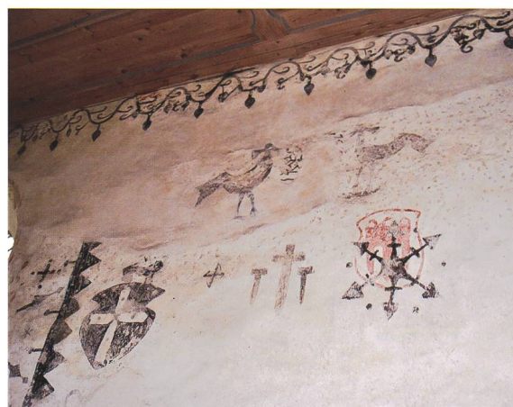
Abb. 21: Langhaus südwand nahe der Empore.
