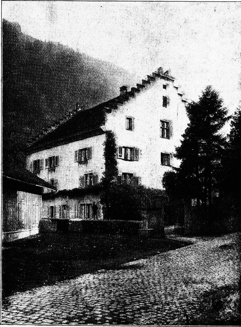
Das Jauch'sche Haus in Aatorf (Uri). 1799 Quartier General Suworoffs.
