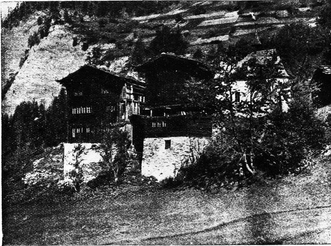
Binn. Häusergruppe „Zu Binnen“ (Keller, Wohnung und Speicher im gleichen Bau).
