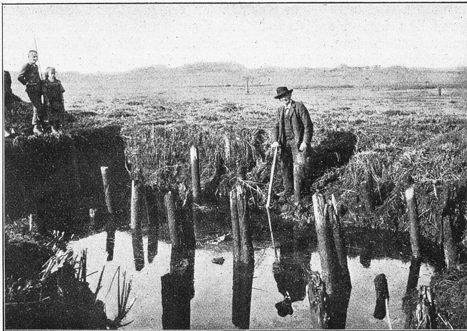
Messikommer an dem von ihm entdeckten Pfahlbau in Nohenhausen.
