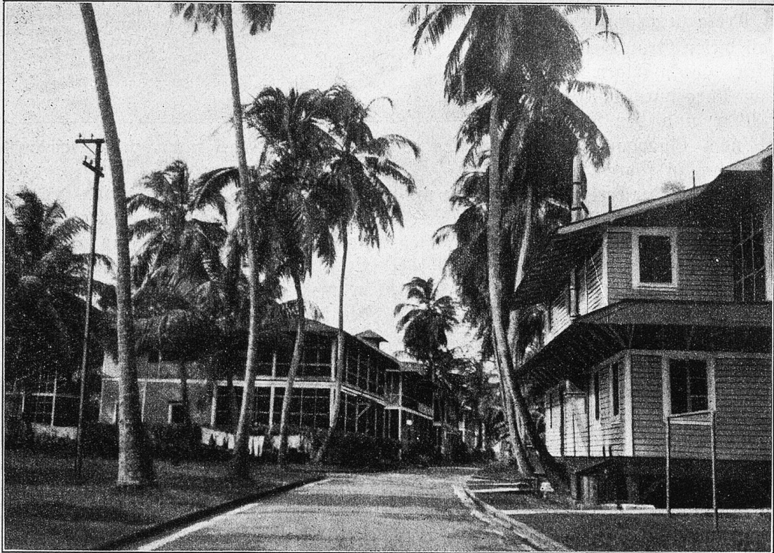
Colon. Moskitosichere Beamtenwohnungen in der Nähe des Hafens.
