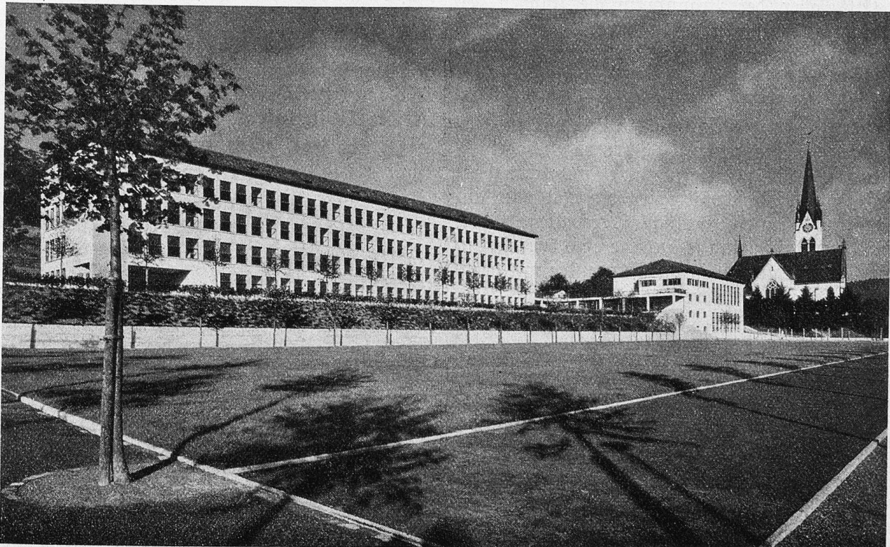
Neues Schulhaus „Waidhalde“ Zürich-Wipkingen.
