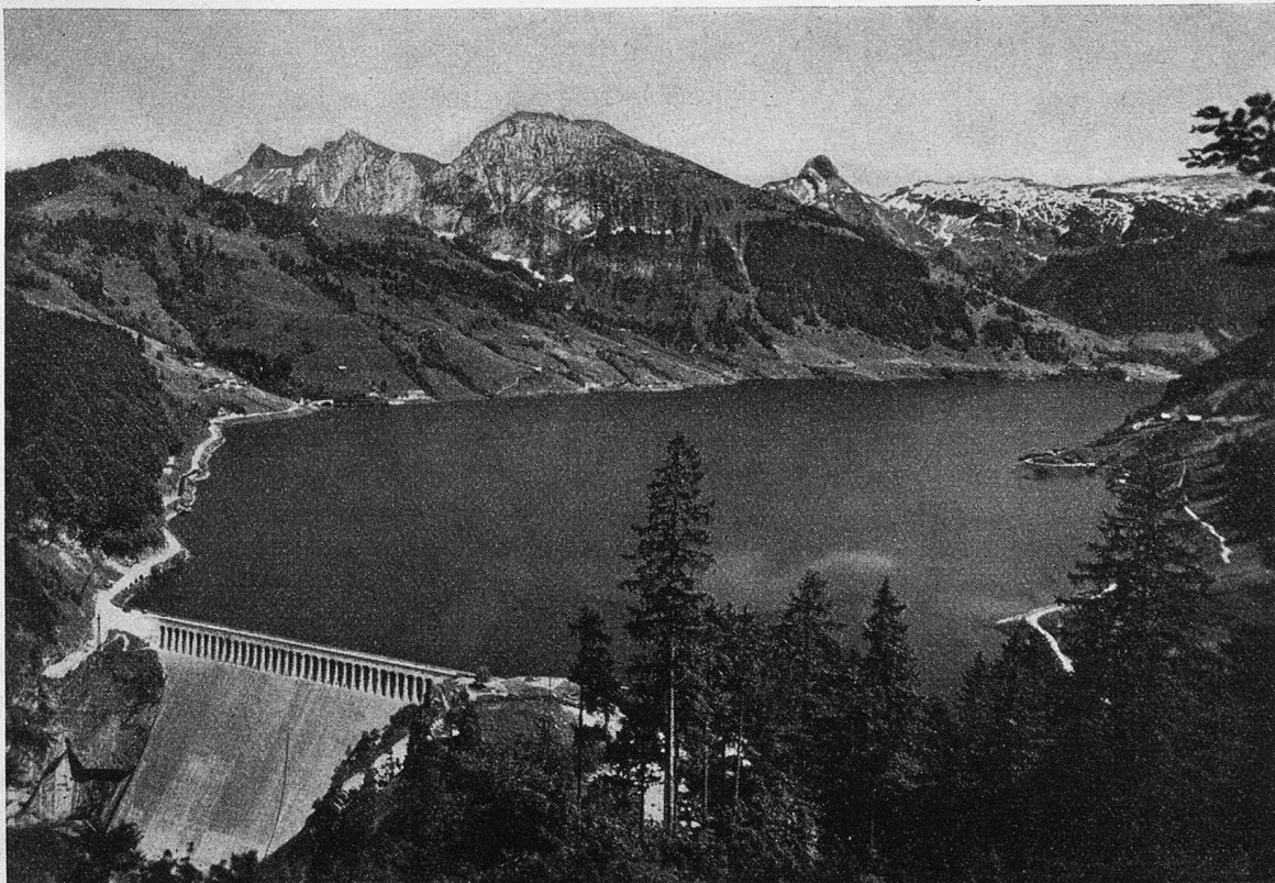
Die Staumauer am Wäggitalsee.
