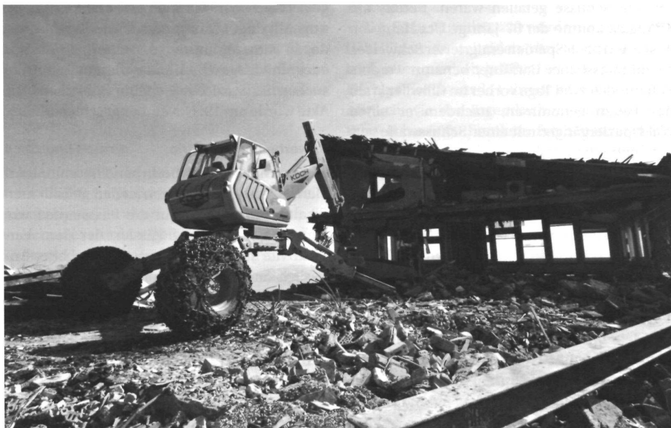
Rückbau des Bergrestaurants auf dem Hohen Kasten.
