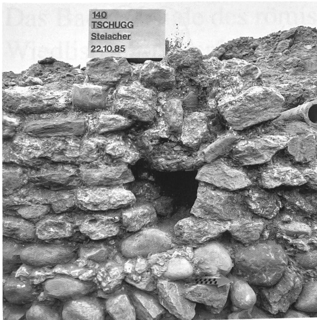
Abb. 9: Tschugg-Steiachger 1985. Schräger Durchbruch durch Mauer M2 – Wasserzuleitung zum Badetrakt 1977?
