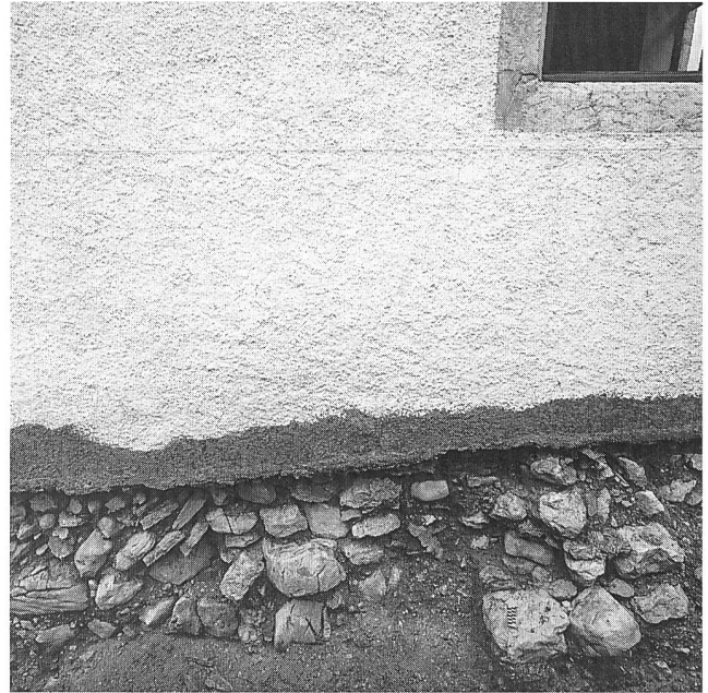
Fig. 10: Fondation du mur sud. A droite le reste du mur (10) de l'ancienne sacristie.
