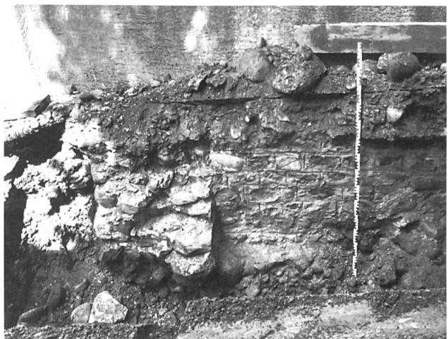
Abb. 19: Bern-Bümpliz - Mauritiuskirche 1969. Umbruch der Mauer a nach Osten. Der Mauerwinkel ist im Verband aufgebaut. Blick nach Westen.
