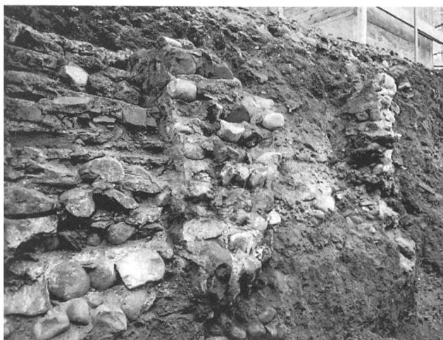
Abb. 13: Bern-Bümpliz - Mauritiuskirche 1968. Befunde in der östlichen Baugrubenwand. Von links nach rechts Hypokaustsockel, Südwand des Raumes A, Südmauer des anschliessenden Ganges. Blick nach Südosten.
