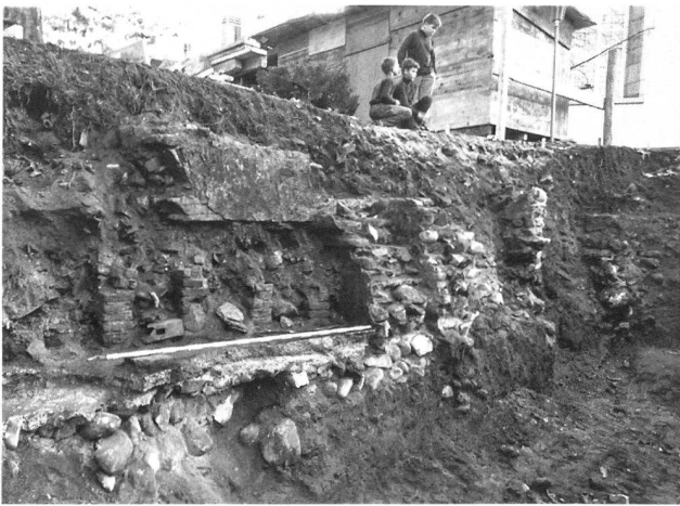
Abb. 15: Bern-Bümpliz - Mauritiuskirche. Raum A, östliche Baugrubenwand. Hypokaustpfeiler mit darüberliegender Mauer in Leichtbauweise. Im Hintergrund Südmauer des Raumes A und die südlich davon verlaufende Gangmauer. Am rechten Bildrand der kleine, gemauerte Abwasserkanal. Blick nach Südosten.
