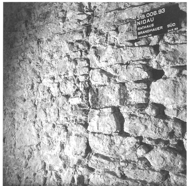
Abb. 8: Nidau, Rathaus. Südmauer (107) mit dem östlichen Eckverband des südlichen Kernbaus.
