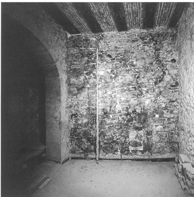
Abb. 7: Nidau, Rathaus. Nordmauer (22) mit dem südwestlichen Eckverband des nördlichen Kernbaus.
