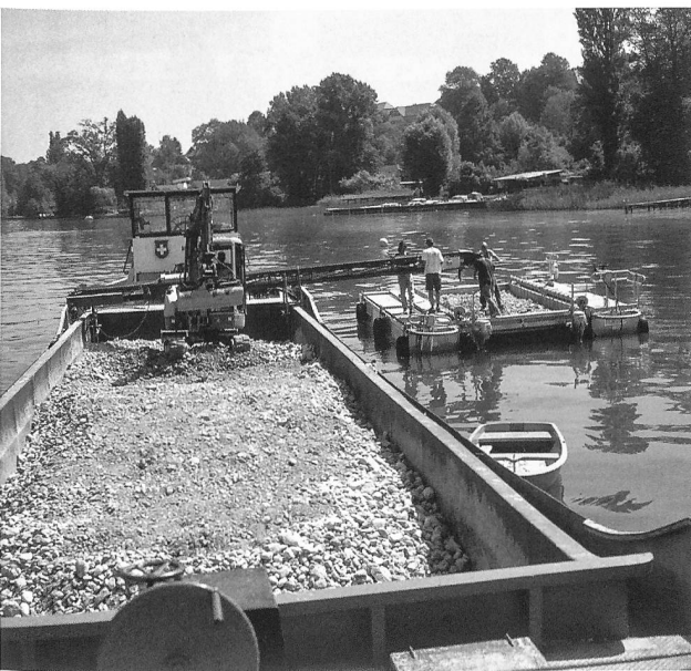
Abb. 46: Sutz-Latrigen, Erosionsschutzmassnahmen 2003. Umladen des Kieses mit Hilfe von Bagger und Förderband.
