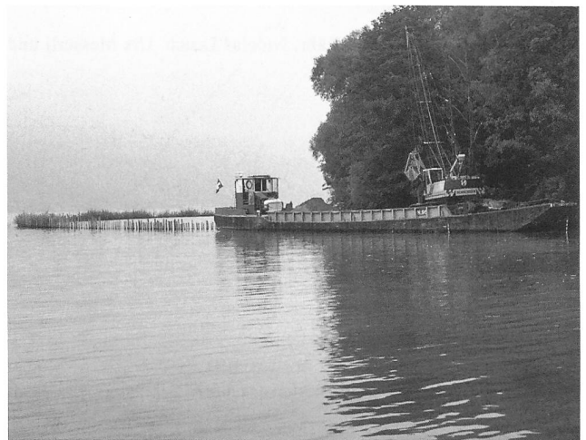
Abb. 61: Sutz-Lattrigen - Rütte 1998. Kiesschüttung zur Sohlensicherung der Lahnung im bereits ausgegrabenen Bereich. Blick nach Nordosten.
