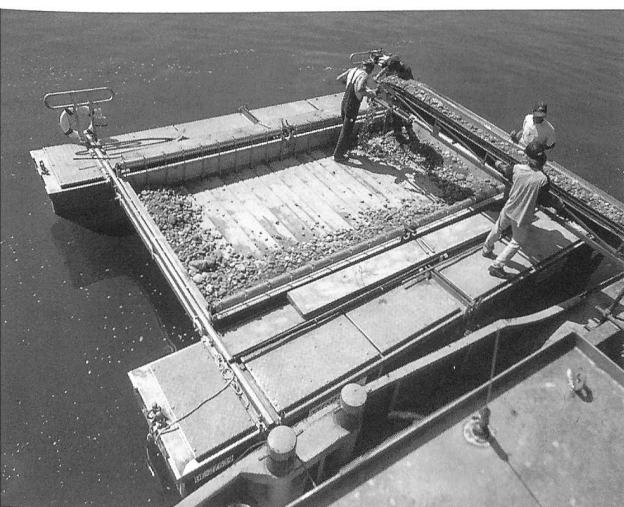
Abb. 47: Sutz-Latrigen, Erosionsschutzmassnahmen 2003. Der Kieskatamaran mit Jalousieboden wird mit Kies gefüllt.
