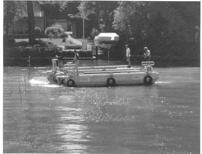
Abb. 48: Sutz-Latrigen, Erosionsschutzmassnahmen 2003. Der Kieskatamaran wird an die markierte Verklappungsstelle manövriert.
