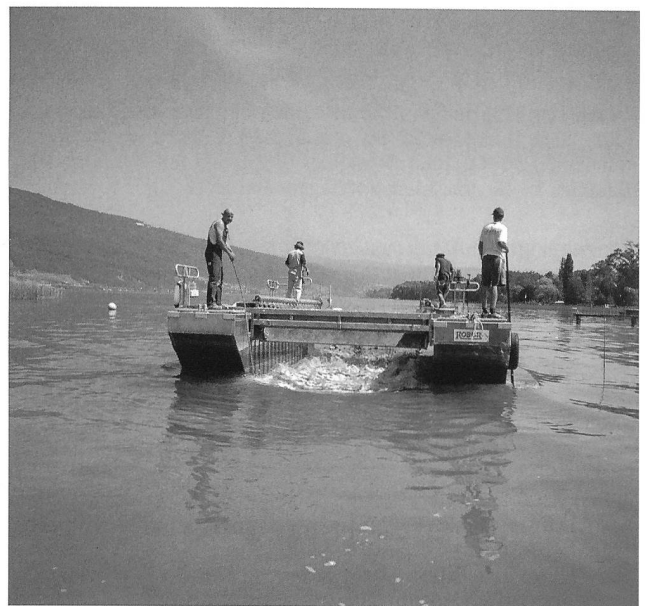
Abb. 49: Sutz-Latrigen, Erosionsschutzmassnahmen 2003. Verklappen des Kieses an der vorgesehenen Stelle.
