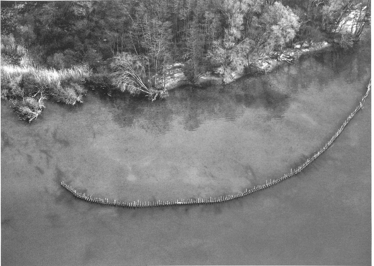
Abb. 59: Sutz-Lattrigen - Rütte 1998. Bau des Wellenbrechers. Die Doppelpfahlreihe für die Lahnung wurde in den Wintermonaten erstellt. Blick nach Osten.
