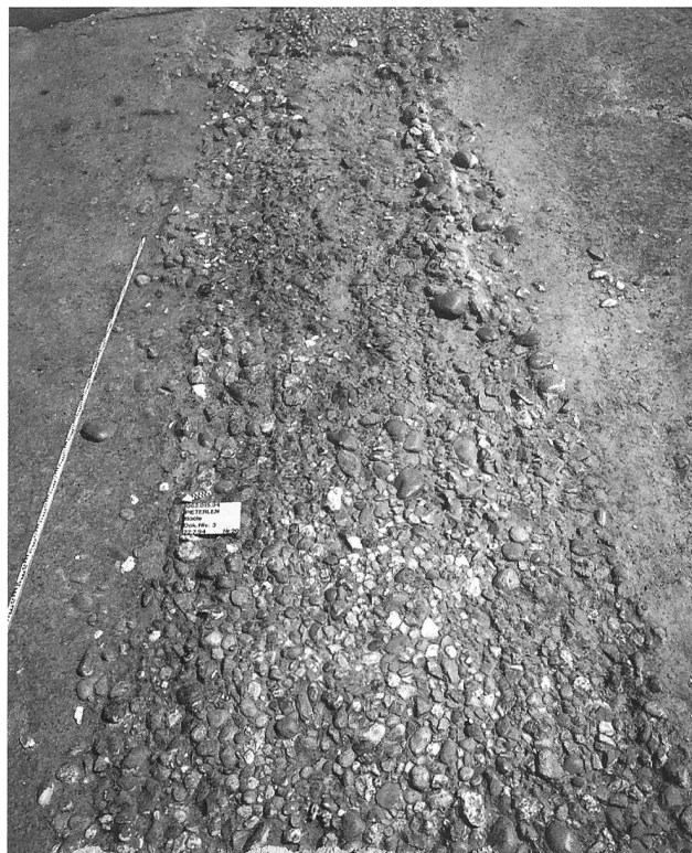
Abb. 16: Pieterlen - Boole 1994. Römische Kiesstrasse. Blick nach Osten.
