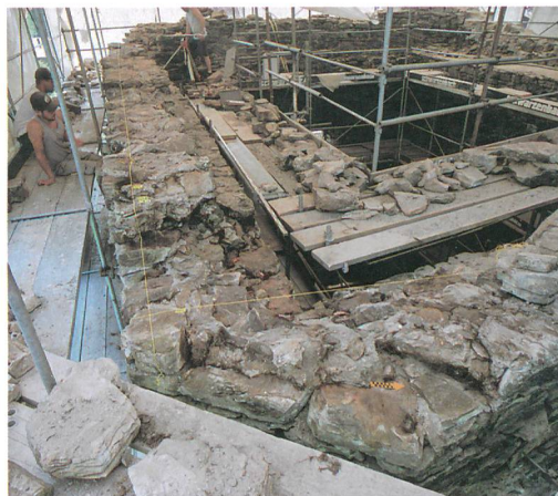
Abb. 12: Ringgenberg, Burgruine. Sanierung der Mauerkrone des Bergfrieds.
