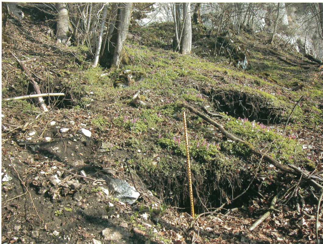
Abb. 5: Niederbipp, Erlinsburgen. Schäden durch ungenehmigte Raubgrabungen.
