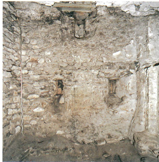
Abb. 17, links: Wohnturm, Inneres nach Westen im heutigen Zustand.
