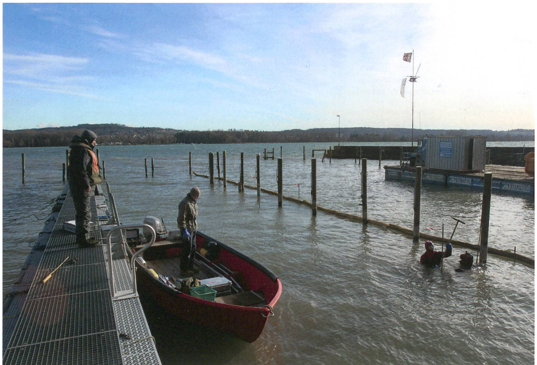
Abb. 4: Biel-Vingelz, Hafen. Bohrsondierung der Tauchequipe des ADB, Januar 2008, im Hafenbecken.
