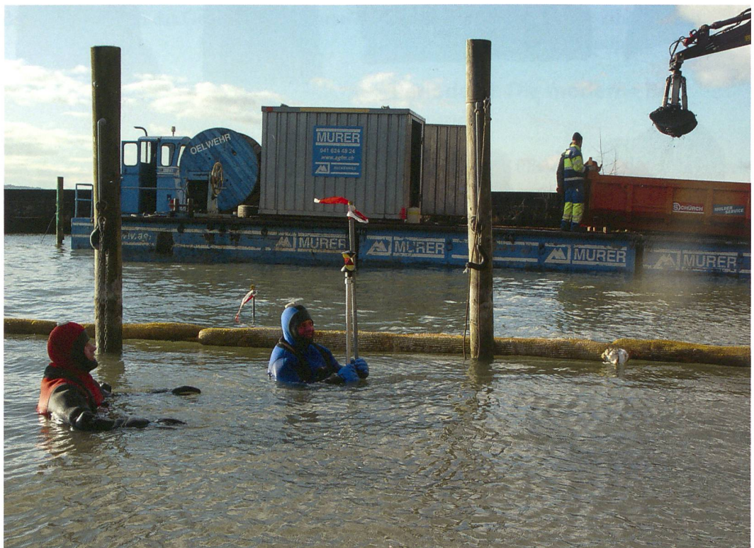
Abb. 1: Biel-Vingelz, Hafen. Arbeitssituation mit Marco Amstutz und Rolf Stettler im Januar 2008 während den Bohrsondierungen.
