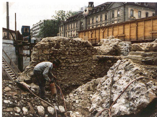
Abb. 9: Bern, Bahnhofplatz. Nur wenige Reste konnten dem Abbruchzahn widerstehen. Im Hintergrund die Fassade des Burgerspitals. Aufnahme Juli 1972.
