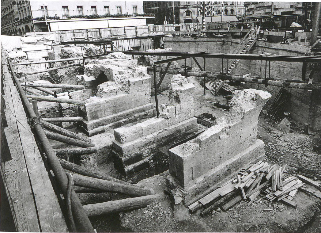
Abb. 7: Bern, Bahnhofplatz. Die Reste der Grabenbrücke. Aufnahme August 1972, Blick nach Südosten.
