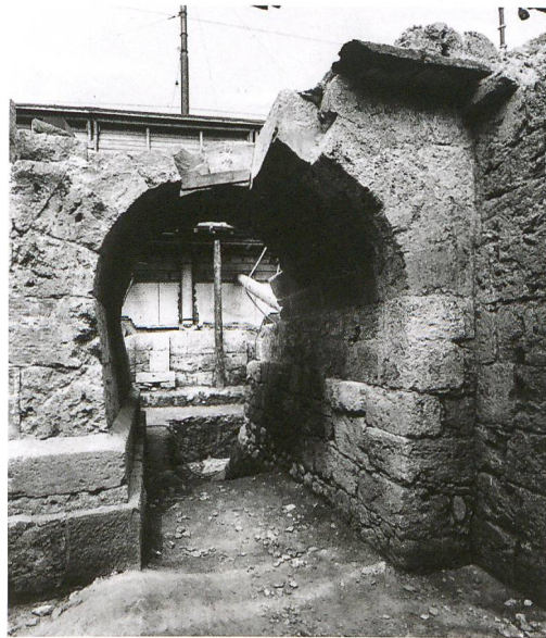
Abb. 8: Bern, Bahnhofplatz. Das erste Brückenjoch von Süden, Aufnahme 20. 7. 1972. Deutlich ist über dem ersten Bogen die vorkragende Tuffplatte, welche die Nähe der Fahrbahn andeutet, zu sehen.
