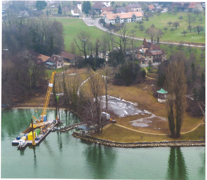
Abb. 2 und 3: Sutz-Lattrigen. Bau der neuen Tauchbasis Bielersee. Sämtliche Transporte kamen über den Wasserweg und die Arbeiten wurden von einem Schwimmponton aus ausgeführt.
