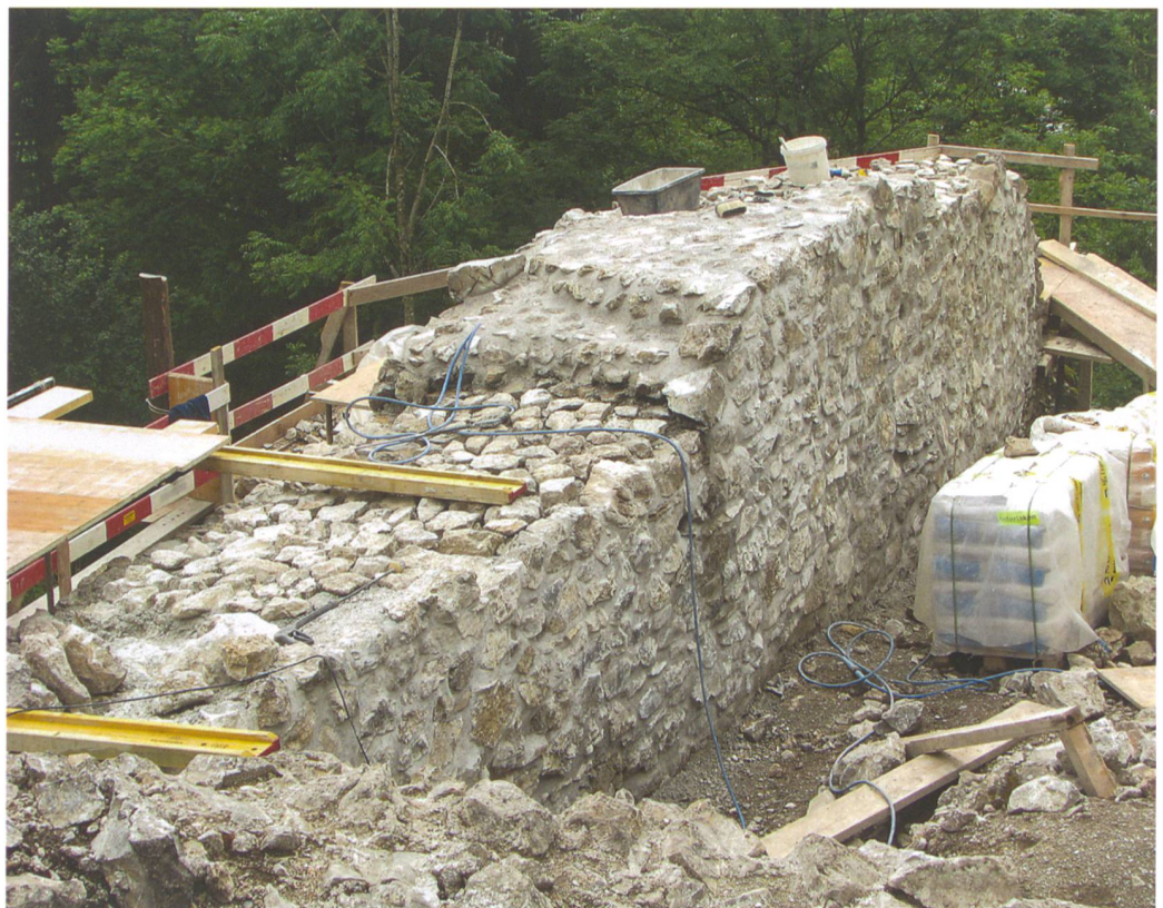
Abb. 5: Zweissimmen, Unterer Mannenberg. Wiederaufmauerung der obersten Mauerlagen. Blick auf die östliche Ringmauer von Norden.
