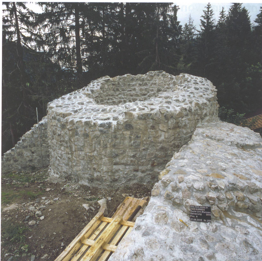
Abb. 7: Zweisimmen, Unterer Mannenberg. Der Rundturm der Phase II in restauriertem Zustand. Blick von Süden.
