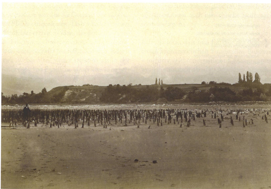
Abb. 9: Mörigen. Berühmtes Bild der freiliegenden Siedlungsreste von Mörigen. Mit der Ersten Juragewässerkorrektur wurde der Seespiegel des Bielersees um etwa 2 m abgesenkt. Dieser massive Eingriff sorgt heute für Schäden durch die Erosion der Flachwasserzone.
