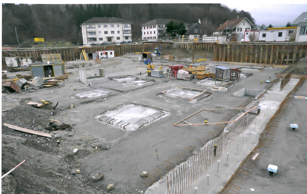
Abb. 1: Studen, Areal Wydenpark. Die Grabung ist abgeschlossen und die Fundationsarbeiten für das Untergeschoss der Grossüberbauung in vollem Gang. Nichts ist mehr zu sehen von Römerstrasse und Holzbrücke.
