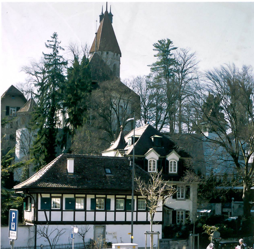
Abb. 6: Thun, Schlossberg, Kirchhofmauer. Ansicht 2012 nach Abschluss der Restaurierung.
