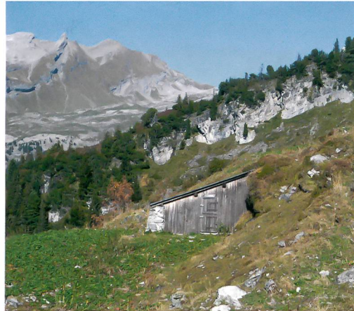
Abb. 17: Innertkirchen, Bäregg. Geschützter Standort einer heutigen Alphütte. Blick nach Nordosten.
