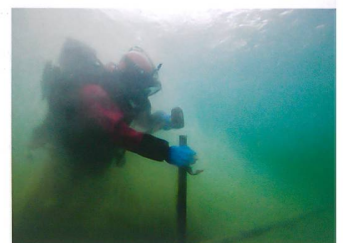
103 Sutz-Lattrigen, Solermattweg, Hafenanlage
