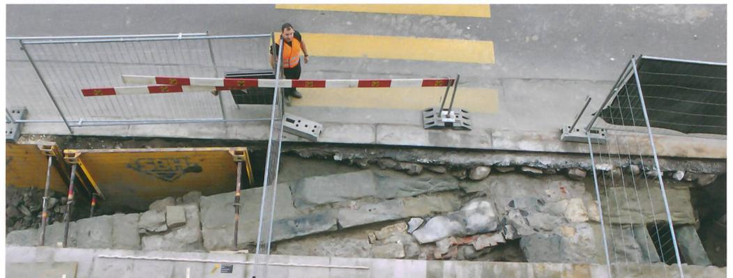
verläuft. Es handelt sich hierbei um die Mauer eines Abwasserkanals, der mit Schieferplatten abgedeckt war. Dieser war begehbar und schloss an das vom Bundesplatz bekannte neuzeitliche Entwässerungssystem an.
