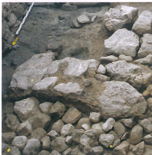
Fig. 19: Moutier, Rue Centrale 57. Enduit de mortier recouvrant la paroi nord du mur 95, mis au jour en 2012 dans la cave de l'ancien Hôtel du Cerf.
