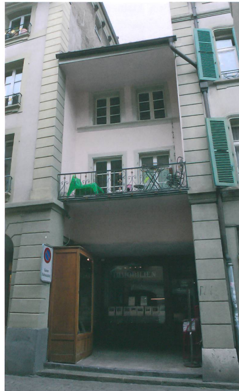
Abb. 2: Thun, Obere Hauptgasse 3. Das untersuchte Stadthaus zeigt mit seiner rückversetzten Fassade den bauzeitlichen Zustand kurz nach 1571. Die Fenster mit hölzernen Faschen und Gesims sowie die Traufverbreiterung stammen aus dem ausgehenden 18. Jahrhundert. Die rückversetzte Ladenfront entstand im frühen 20. Jahrhundert. Blick nach Nordosten.
