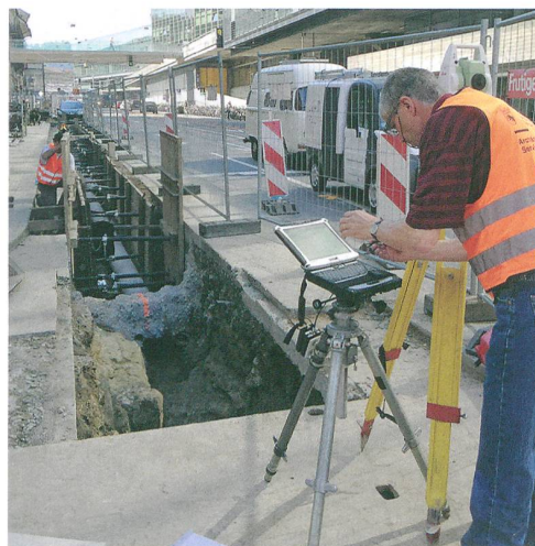
Abb.1: Bern, Bollwerk. Werkleitungssanierung im Sommer 2013. Blick nach Süden.
