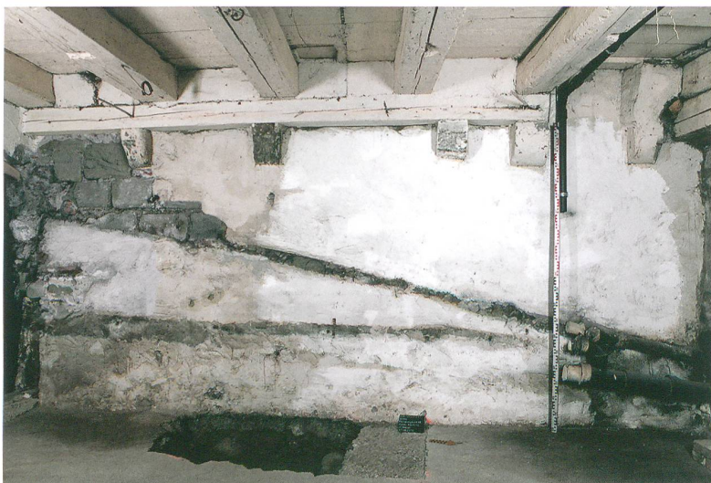
Abb. 1: Bern, Rathausgasse 68. Erdgeschoss im Hinterhaus des Anwesens mit brandgerötetem Mauerwerk und Balkendecke der Zeit um 1470 (dendrodatiert). Blick nach Westen.
