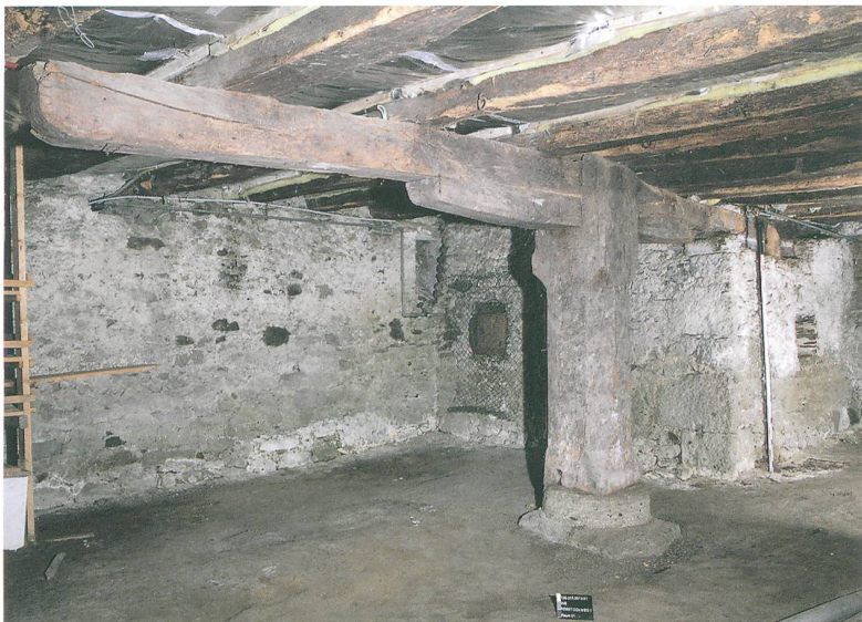
Abb. 2: Ins, Rebstockweg 7. Ursprünglich als Kellerraum genutzter Keller des Anwesens «Himmelrich».
