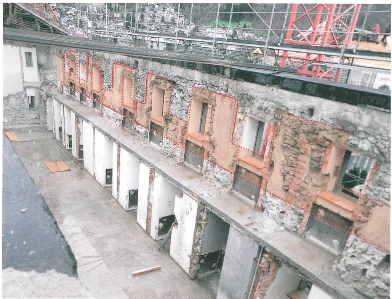
Abb. 5: Thun, Schloss. Wohngeschoss im Torturm mit Kamin und Fenstern. Blick nach Südosten.
