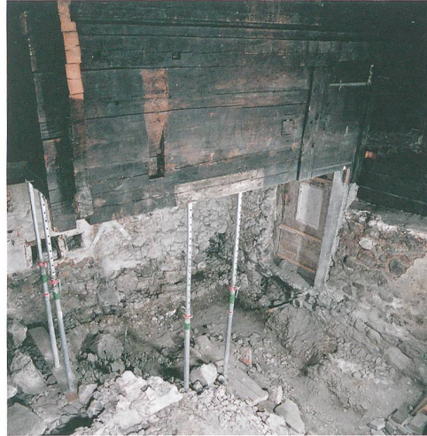
Abb. 16: Erlenbach, Ringoldingen, Heidenhaus. Blick vom Obergeschoss in den rückwärtigen Küchenraum während den Umbaumaassnahmen. An der Ostwand des Gaden 6 / Zimmers 7 zeigt sich die Deckennut und die Erschliessungstür zum Vorgängergaden 5 deutlich. Blick nach Nordwesten.
