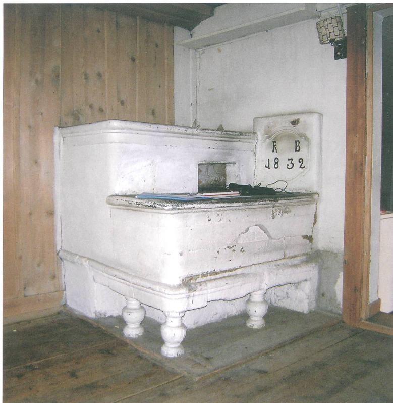
Abb. 6: Erlenbach, Ringoldingen, Heidenhaus. Trittofen aus Sandstein. Die Ofenplatte mit der Inschrift «R B 1832» wurde sekundär in diese Mauer aus rezenten Backsteinen eingebaut. Blick nach Nordwesten.
