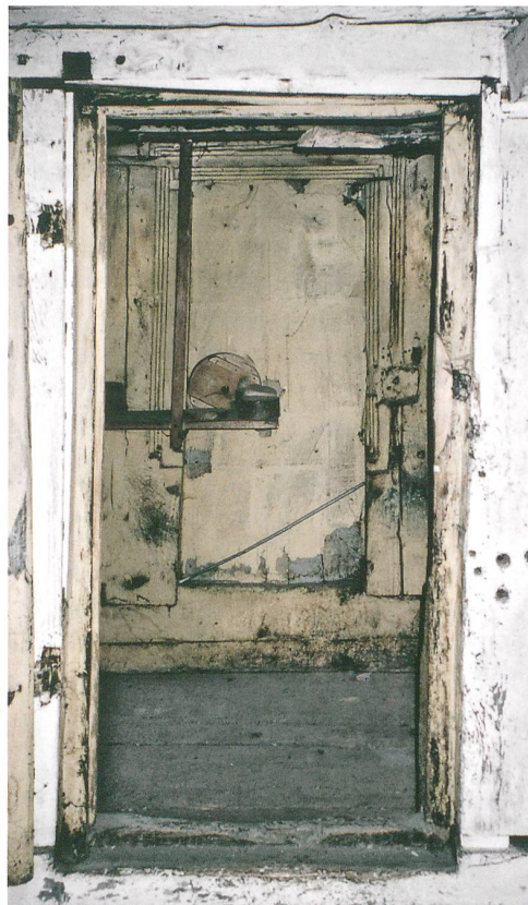
Abb. 5: Erlenbach, Ringoldingen, Heidenhaus. Westlicher Hausteil, Obergeschoss. Blick aus Gaden 1 an die Gadenür zu Gaden 2. Das Türgevände ist mit einem von Hohlkehlen gesäumten Falz verziert. Solche vergleichsweise reichen Dekorelemente wurden mittels Profilhobel an den Bauteilen angebracht. Blick nach Osten.
