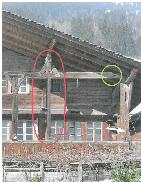
Abb. 28: Erlenbach, Ringoldingen, Heidenhaus. Südfassade. Roter Kreis: Der Ständer wurde nachträglich unter die untere Mittelfette gestellt. Grüner Kreis: Beim Einsetzen des zusätzlichen Eckständers musste die Kopfstrebe abgesägt werden. Blick nach Norden.
