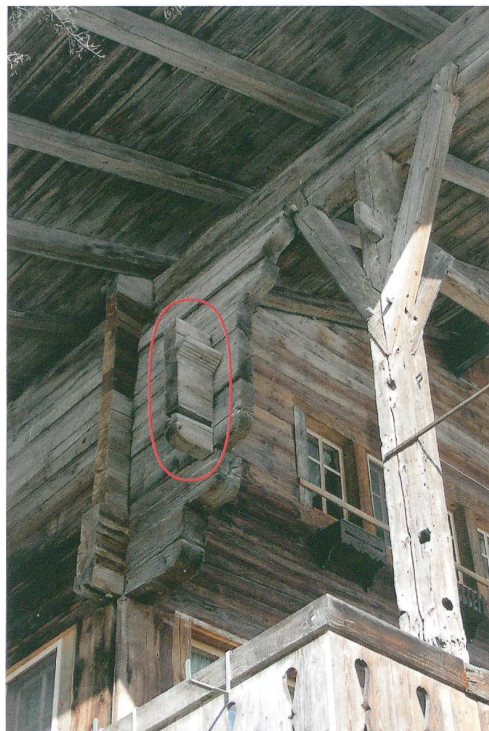
Abb. 19: Erlenbach, Ringoldingen, Heidenhaus. Blick an die südwestliche Hausecke. Im Obergeschoss bildet der überkämmt Vorstoss der Westwand einen Hinweis auf eine Gadenlaube (rot eingekreist). Im östlichen Hausteil fehlen entsprechende Beobachtungen. Blick nach Nordosten.
