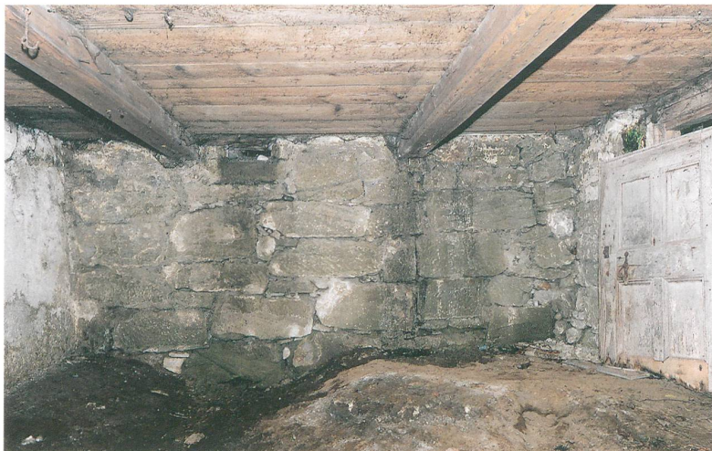
Abb. 20: Schwarzenburg, Junkerngasse 17. Die beiden «Träme» des südöstlichen Kellers trugen den Stubenfussboden und fingen die Auflast des Ofens durch einen nicht erhaltenen Ständer ab. Die einzige nicht verputzte Wand besteht aus wiederverwendetem Altmaterial. Könnten hier die Reste des alten Webkellers verbaut worden sein? Blick nach Nordosten.
