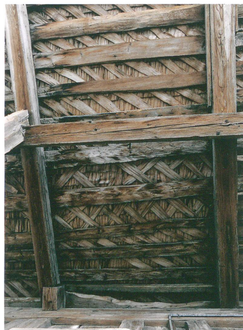
Abb. 12: Schwarzenburg, Junkerngasse 17. Blick in den Vordachbereich am Querbund 3 mit Flugpfette und Vordachbug (links). Auf der mehrfach umgesetzten Dachlattung haben sich grössere Flächen der alten Nagelschindeleindeckung erhalten.
