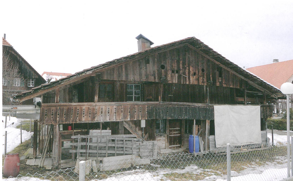
Abb. 1: Schwarzenburg, Junkerngasse 17. Die giebelseitige Fassade wird vom flachen Giebeldach, den Resten des verbretterten Wetterschildes und der darunter befindlichen Laube dominiert. In der Mitte des Erdgeschosses ist der Eingang zur Küche erkennbar. Blick nach Nordwesten.
