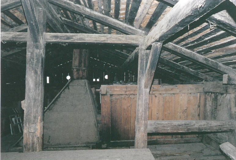
Abb. 11: Schwarzenburg, Junkerngasse 17. Dachraum mit der südöstlichen Hälfte des Querbundes 3. Der Ankerbalken (unten rechts) ist nur noch zwischen Wandständer und Mittelpfettenständer erhalten. Auf der Wandpfette (rechts) sorgt ein sparrenknechtartiger Stichbalken für einen kraftschlüssigen Sitz des Rofens. Im Hintergrund das Bretterkamin und die Rückseite des Gadens. Blick nach Osten.
