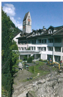
108 Unterseen, Auf dem Graben
