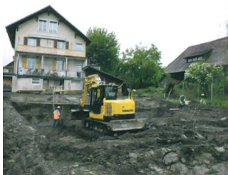
56 Kirchlindach, Lindachstrasse 12b
