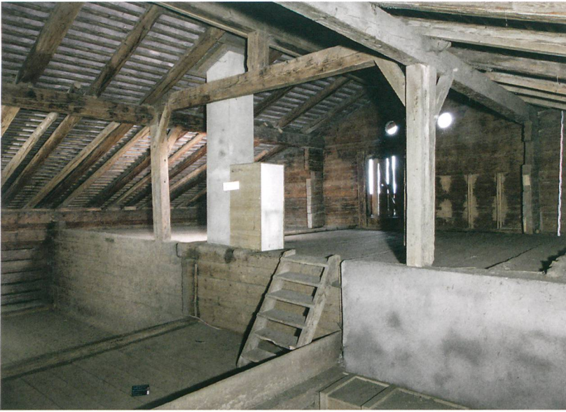
Abb. 6: Thun, Goldiwil, Matthauserweg 23. Dachraum hinter der Giebelwand mit stehender Dachstuhlkonstruktion. Links im Bild ist die Gimmwand mit der Gadenwand überkämmt. Blick nach Südwesten.
