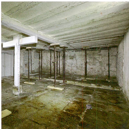
Fig. 2 : Bienne, rue Karl-Neuhaus 3. Le rez-de-chaussée se composait de deux pièces, dont le sol était couvert d'un magnifique dallage calcaire. Le solide solivage à voutain du plafond est aussi d'origine. Vue vers le nord.
