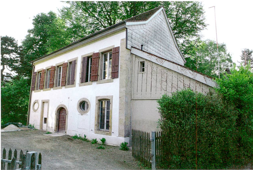
Fig. 1 : Bienne, rue Karl-Neuhaus 3. Ce bâtiment abritait la cuisine de couleurs de la fabrique d'indiennes Verdan & Cie. Situation avant travaux, vue vers l'est.
