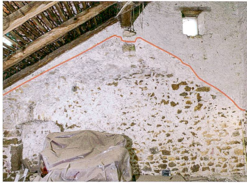
Abb. 3: Twann-Tüscherz, Dorfgasse 9c. Nordmauer mit Abdruck des ursprünglichen Daches (rote Linie); in der Ecke links unten, das ursprüngliche Fenster (31).
