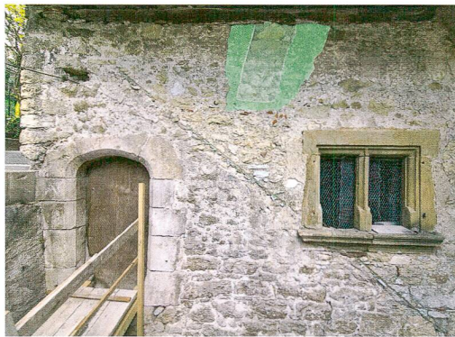
Abb. 4: Twann-Tüscherz, Dorfgasse 9c. Westfassade mit Bogenportal zum spätmittelalterlichen Primärbau. Kamin- und Fenstereinbau (grün) stammen aus dem späten 17. Jahrhundert.
