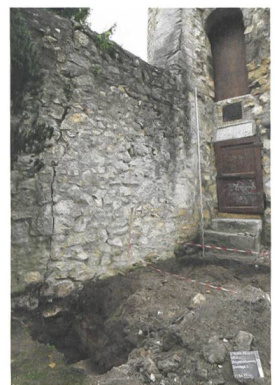
73 Nidau, Strandweg 2, Ziegelhütenturm
