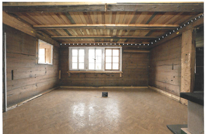
Abb. 3: Adelboden, Hirzbodenportstrasse 10. Blick in die Wohnstube. Die Wände waren bis zur modernen Vertäfelung immer auf Sicht. Die ursprüngliche Deckenhöhe ist am genuteten Deckenrähmbalken noch ablesbar (weisse Punkte). Blick nach Südwesten.
