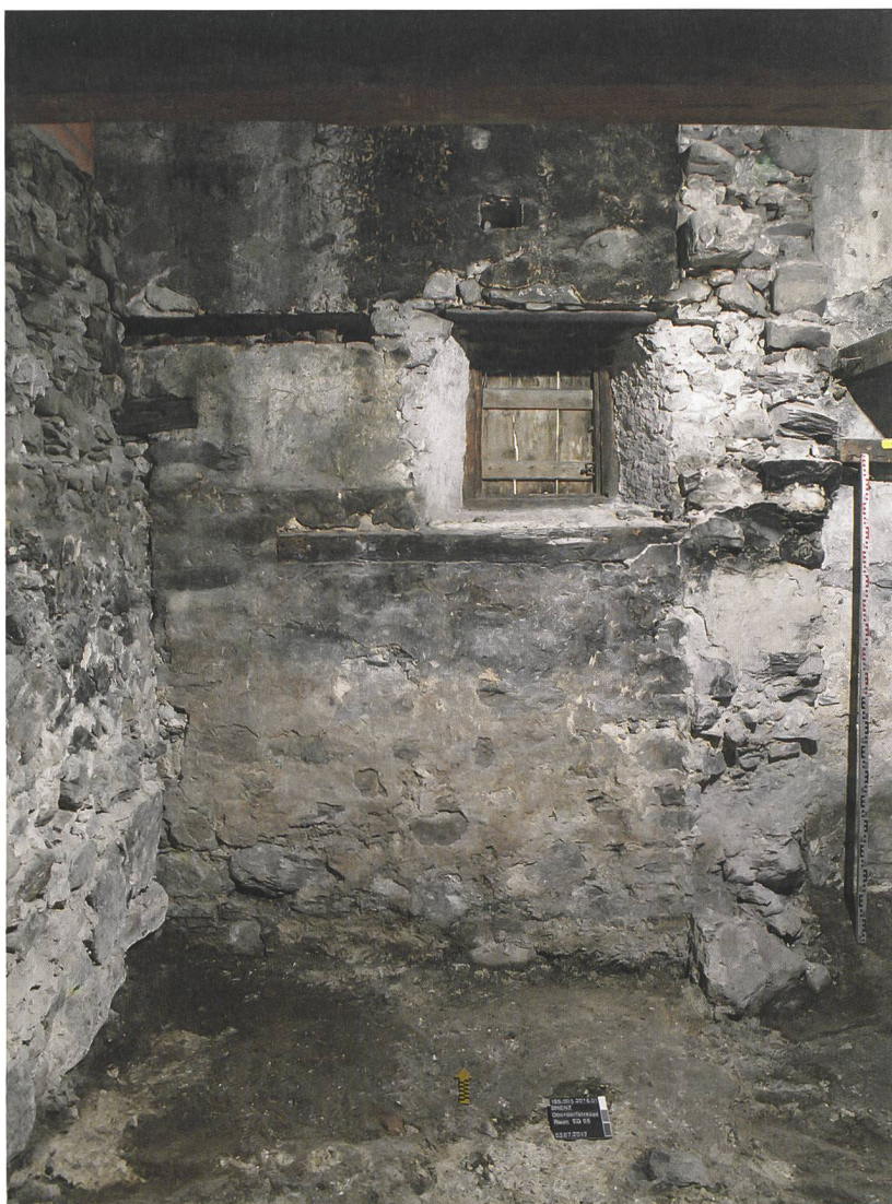
Abb. 6: Brienz, Oberdorfstrasse 92. Giebelwand im Gewerbetrakt des östlichen Hausteils nach dem Abbau des neuzeitlichen Ofens; links die jüngere Trennwand zwischen den beiden Hausteilen; rechts die Abbruchkante der ursprünglich eingezogenen Hausecke. Blick nach Norden.
