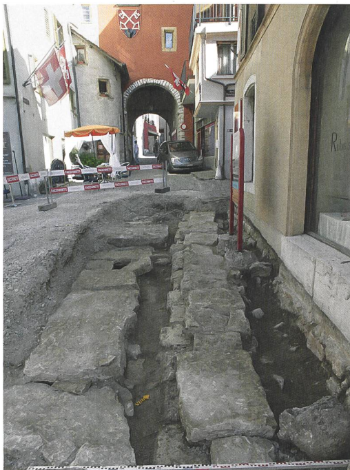
Fig. 7 : La Neuveville, Route cantonale. Deux aqueducs dallés apparus dans le prolongement de la Tour Rouge. Celui de gauche alimente encore le canal à ciel ouvert de la rue du Marché. Vue vers le nord-ouest.
