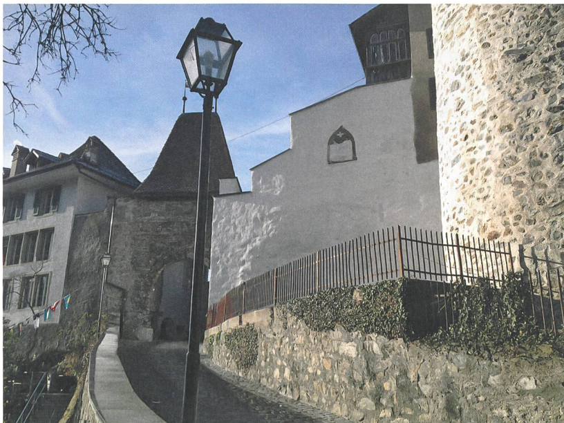
Abb. 3: Thun, Burgitor. Zustand der Mauern nach Abschluss der Sanierung 2016. Blick nach Westen.
